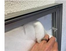
Das Akustikvlies wird mittels einfach zu montierenden Montageclips gehalten. Gleichzeitig sorgen die Montageclips für eine saubere Auflage des Profils auf dem Untergrund.
